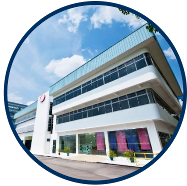
2 Ang Mo Kio St 65
